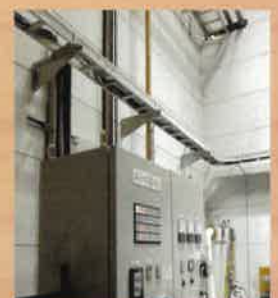
電線配管工事 制御盤・製作設置
