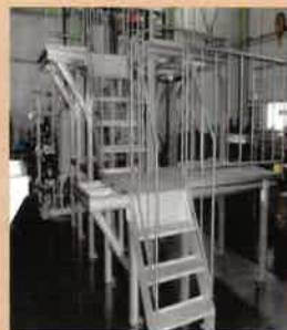
架台製作設置
