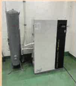
コンプレッサ設置
