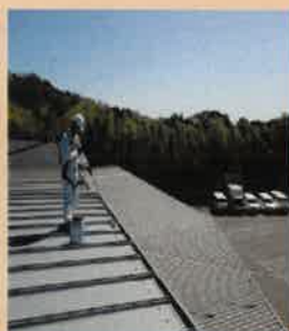
屋根遮熱塗工
