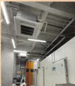
エアコン設置
