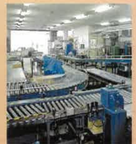
コンベア設置
