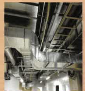
保温・ダクト設置工事
