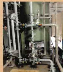
水道配管設置
