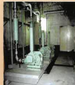
モーター・プロア・ポンプ設置
