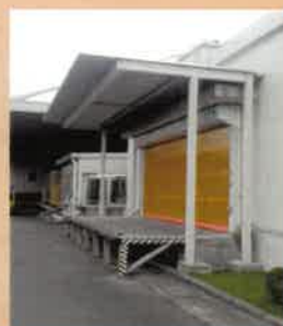
シートシャッター設置
